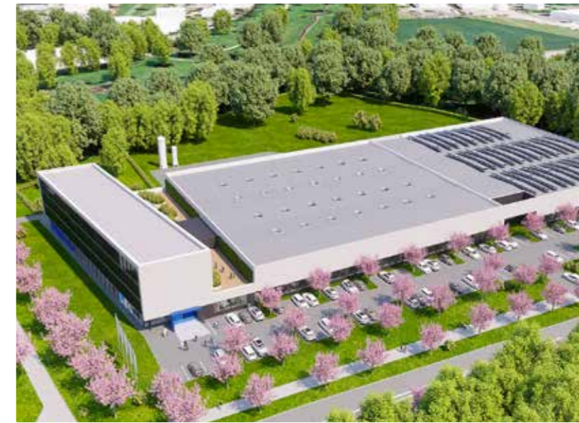
Im Technologiepark Ostfalen entsteht der neue Firmensitz von HORIBA FuelCon.
